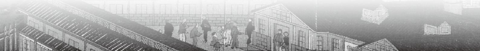
風穴には天然洞穴の冷涼な条件を利用したものもあるが、荒船風穴は、冷風が吹き出す山の斜面に石積みを築き、その上に土蔵造りの建屋をもつ地下二階、地上一階の構造である。貯蔵能力は3基の風穴合計で蚕種紙110万枚に上り、国内最大であった。
