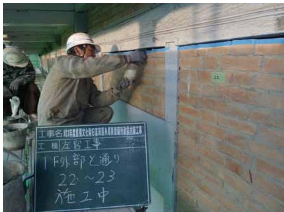
東置蔵所では、レンガ壁上部と桁等横架材下端の間に、目地の乾燥収縮に伴う約2~3cmの隙間が生じていた。耐震強度を高めるため、その隙間に無収縮モルタルを充填した。また、併せて中央通路両側の半枚積みのレンガ壁に転倒防止の補強を行った。
